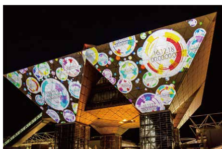
優秀賞「Installation Time」 福井大学
